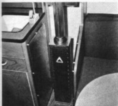
Die Ölheizung hat auch im Caravan Eingang gefunden. Hier der raumsparende „Vesuv“, der in einen Sportberger-Caravan eingebaut wurde.
